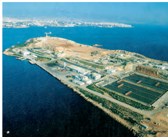
Εικόνα 43.2: Ψυττάλεια, Βιολογικός καθαρισμός
