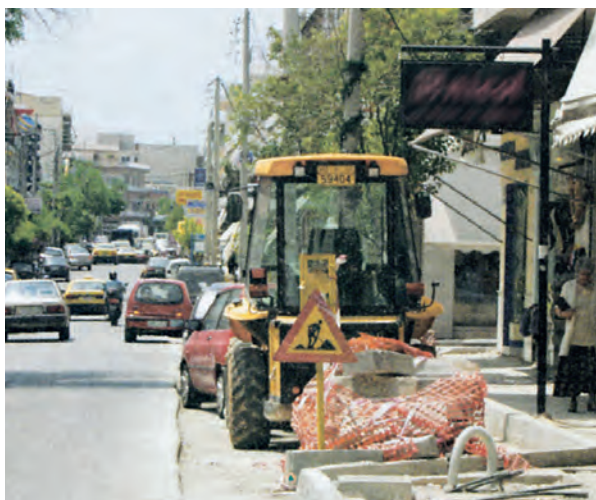
Εικόνα 31.1: Κατασκευή νέων πεζοδρομίων
