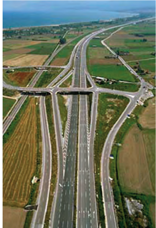
Εικόνα 41.3: Π.Α.Θ.Ε. Νέα Εθνική Οδός. Τμήμα: Δίον-Κατερίνη
